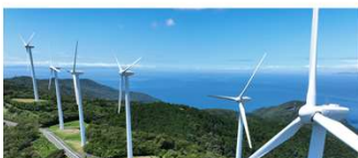
風力発電のブレード清掃
