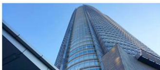
大規模施設の定期メンテナンス
