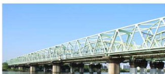
橋梁・煙突・船体など足場が必要な場所
